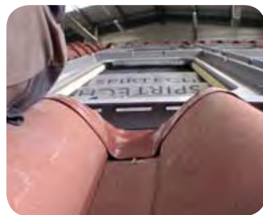
Grille de ventilation.
